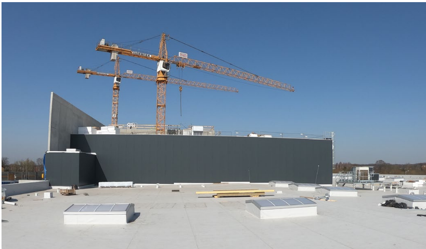
Budowa Galerii Wiślanka w Żorach, fot. Grzegorz Dukata
